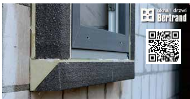
Montaż systemem MOWO
