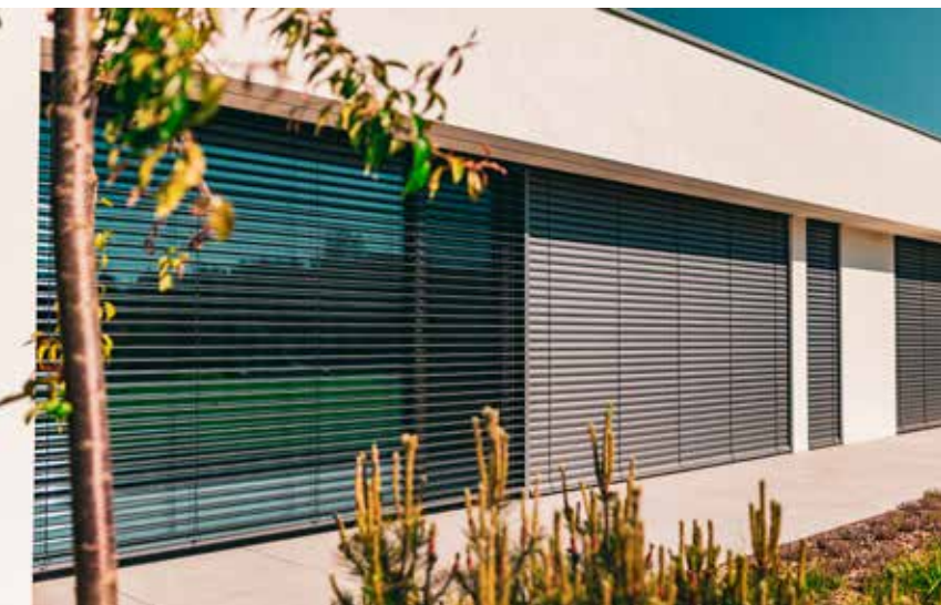
Żaluzje fasadowe, widok z zewnątrz
