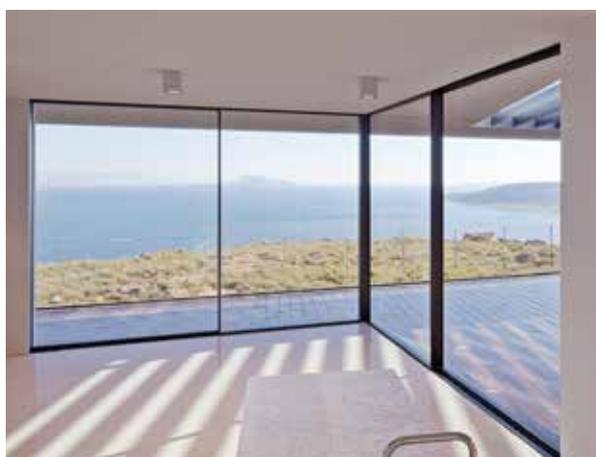
Un système de porte coulissante avec des paramètres d'isolation thermique élevés, avec un cadre étroit dans la zone du joint de châssis.
